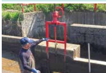
箱井分水工ゲート補修
