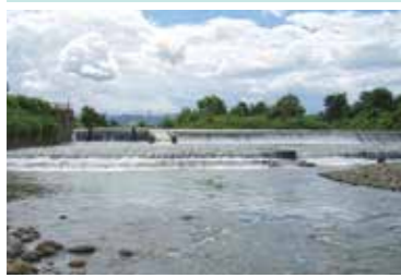
三ヶ字頭首工
