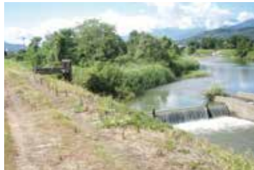
石沢第1頭首工
