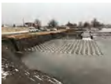
柳井田頭首工
