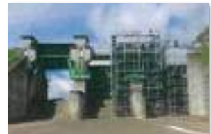
洪水吐ゲートの改修（笹ヶ峰ダム）
