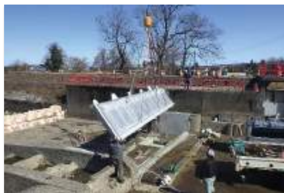
オールステンレス製ゲート据付状況(三ヶ字頭首工)
