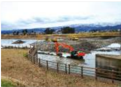
十ヶ字頭首工土砂搬出状況
