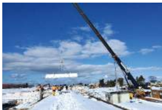
360t クレーンによるゲート据付状況(石沢第1頭首工)
