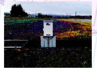
開水路 自動給水管理 (ほくつうHPより)
